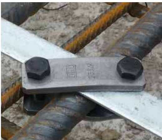
Bild 12: Schraubverbinder für Bandstahl
