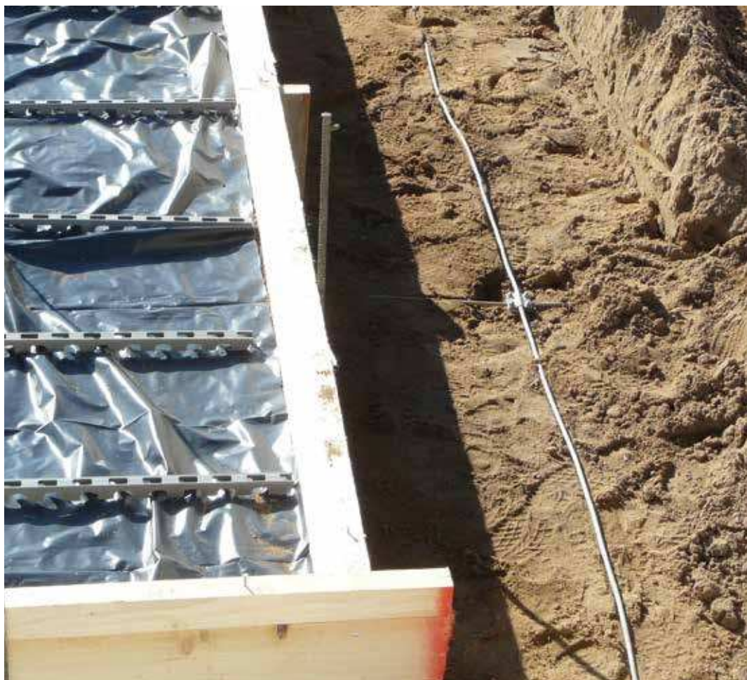
Bild 6: Beispiel für die Ausführung eines Ringerders
