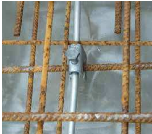
Bild 17: Ausführungsbeispiel für Fundamenterder in der unteren Bewehrungslage
