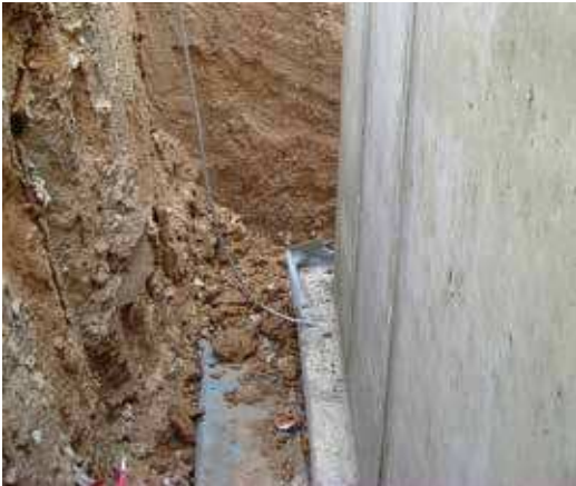
Bild 10: Ausführungsbeispiel einer Anschlussfahne aus Edelstahl (V4A)
