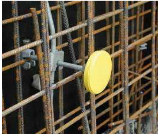
Bild 11: Erdungsfestpunkt
