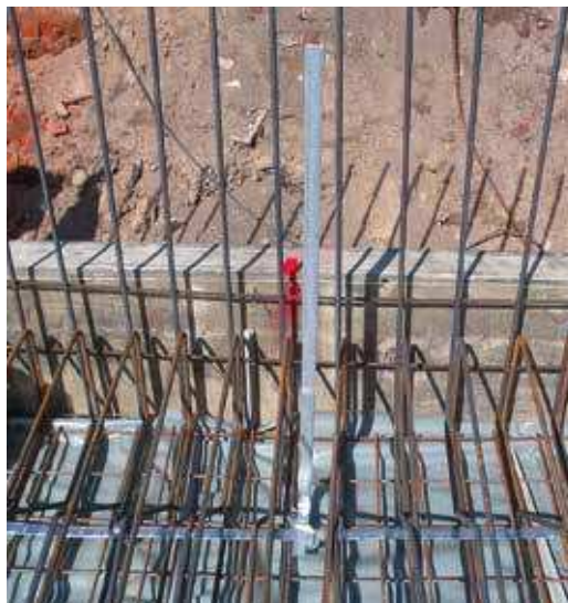
Bild 18: Waagrecht verlegter Fundamenterder in der Fundamentbewehrung
