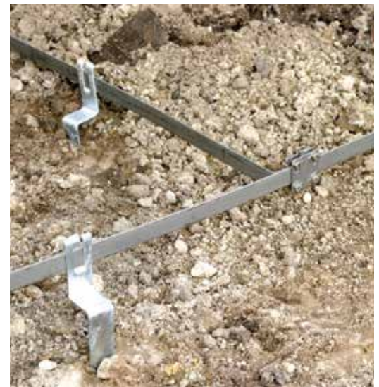
Bild 15: Abstandhalter montiert in der Fundamentsohle
