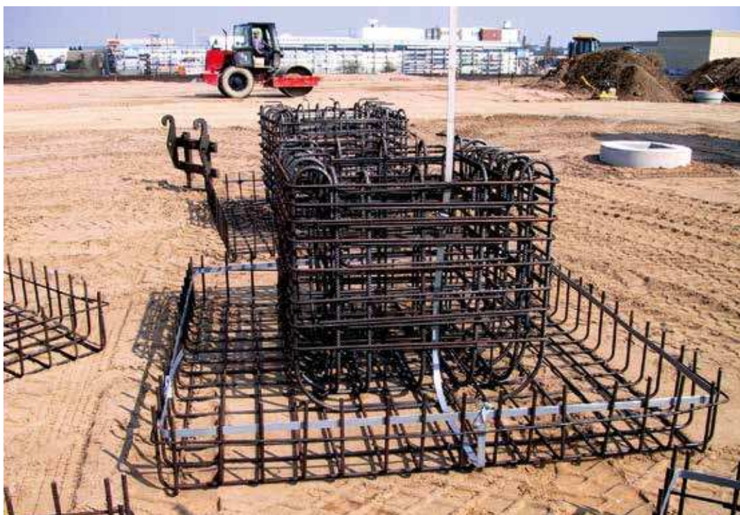
Bild 19: Fundamenterder und Anschlussfahne bei einem Einzelfundament
