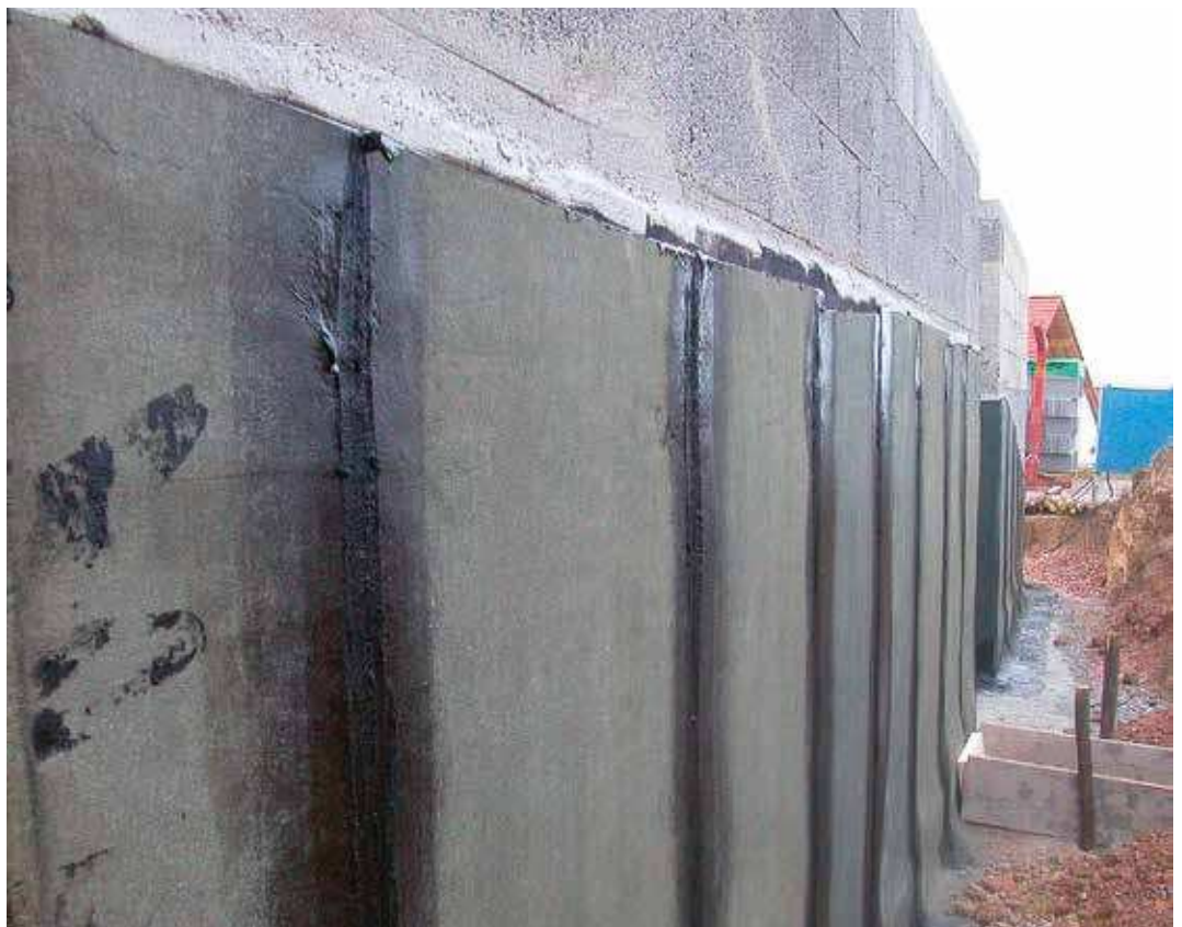
Bild 22: Ausführungsbeispiel einer „schwarzen Wanne“ mit Bitumen-Schweißbahnen
