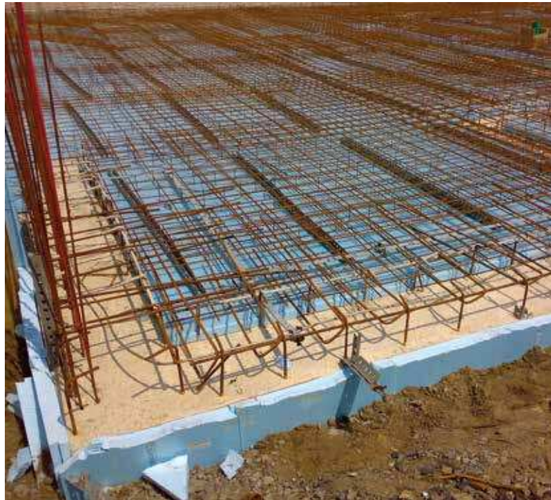
Bild 25: Perimetergedämmte Fundamente mit Erdfähigkeit
